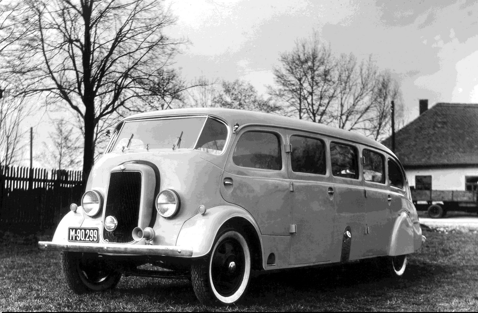
Das Karosseriewerk Sodomka baute 1937 für den Schuhfabrikanten Tomáš Baťa ein aerodynamisches Reisemobil auf'm Fahrwerk von Ford
