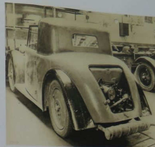
179 Erster Prototyp mit Heckmotor 1931
